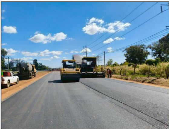
รูปที่ 2.3-2 กิจกรรมการดำเนินงาน ASPHALT CONCRETE UNDER CONCRETE PAVEMENT ที่ กม.34+850 - 35+350 ด้านซ้ายทาง
