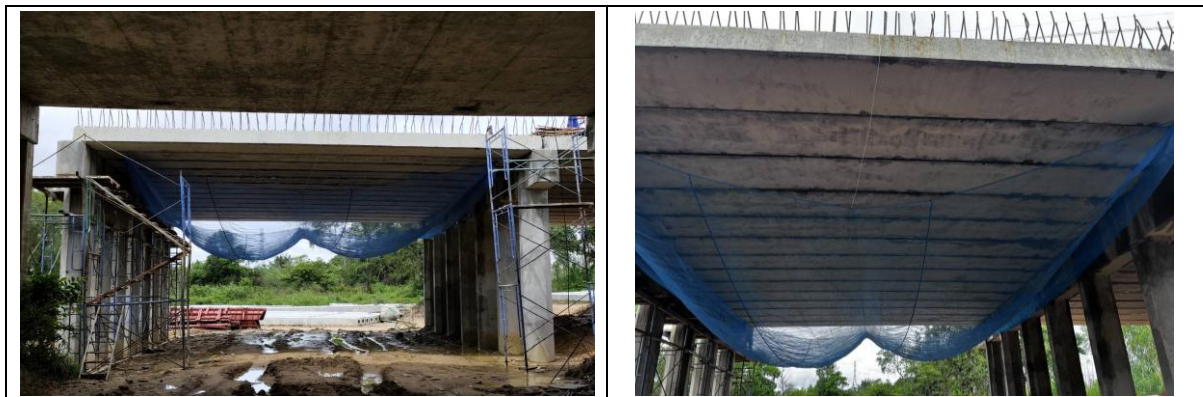
รูปที่ 3.1-13 ติดตั้งตาข่ายใต้สะพานข้ามแหล่งน้ำ
