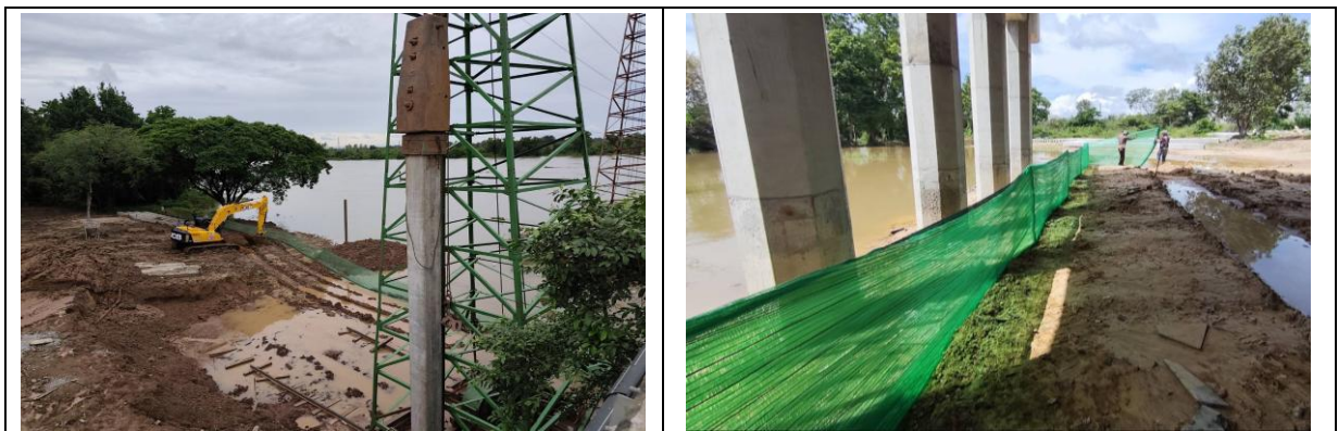
รูปที่ 3.1-4 รั้วดักตะกอนก่อนลงแม่น้ำมูล
