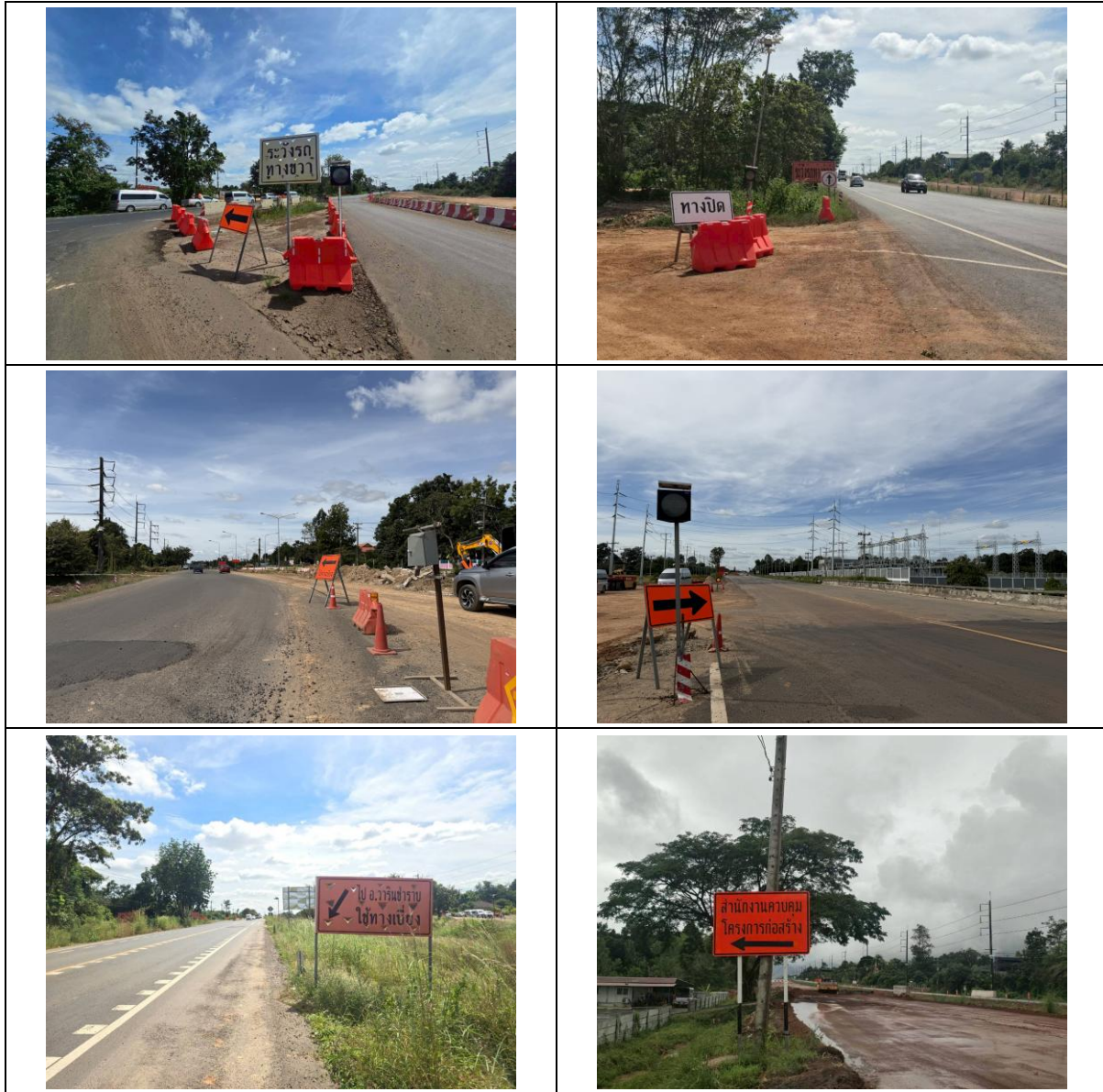
รูปที่ 3.1-17 การติดตั้งป้ายป้ายจราจรต่าง ๆ และการเบี่ยงจราจร (ต่อ)
