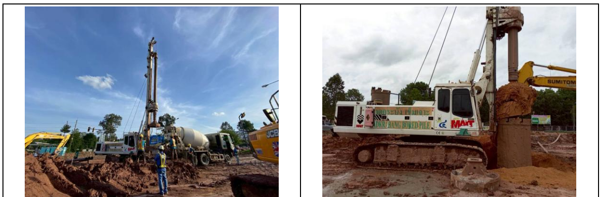
รูปที่ 3.1-27 การก่อสร้างตอม่อโดยใช้เสาเข็มแบบเจาะ
