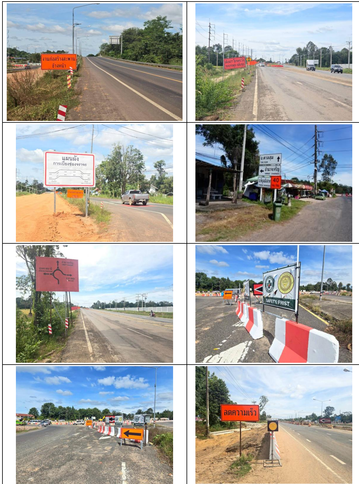
รูปที่ 3.1-17 การติดตั้งป้ายป้ายจราจรต่าง ๆ และการเบี่ยงจราจร
