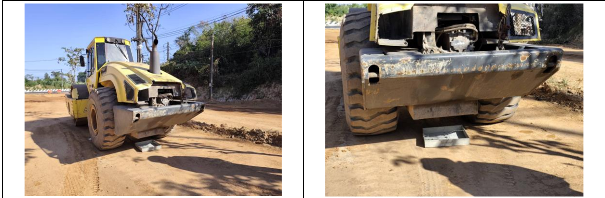
รูปที่ 3.1-9 การป้องกันการปนเปื้อนน้ำมันลงสู่ผิวดินและแหล่งน้ำ (ต่อ)
