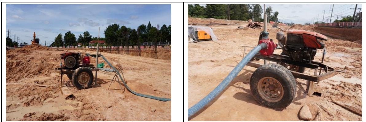
รูปที่ 3.1-15 เครื่องสูบน้ำบริเวณพื้นที่ก่อสร้าง
