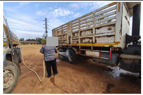
รูปที่ 3.1-22 การล้างทำความสะอาดล้อในพื้นที่โครงการ
