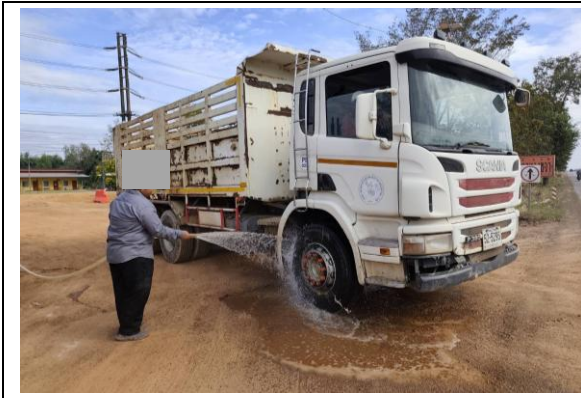
รูปที่ 3.1-22 การล้างทำความสะอาดล้อในพื้นที่โครงการ
