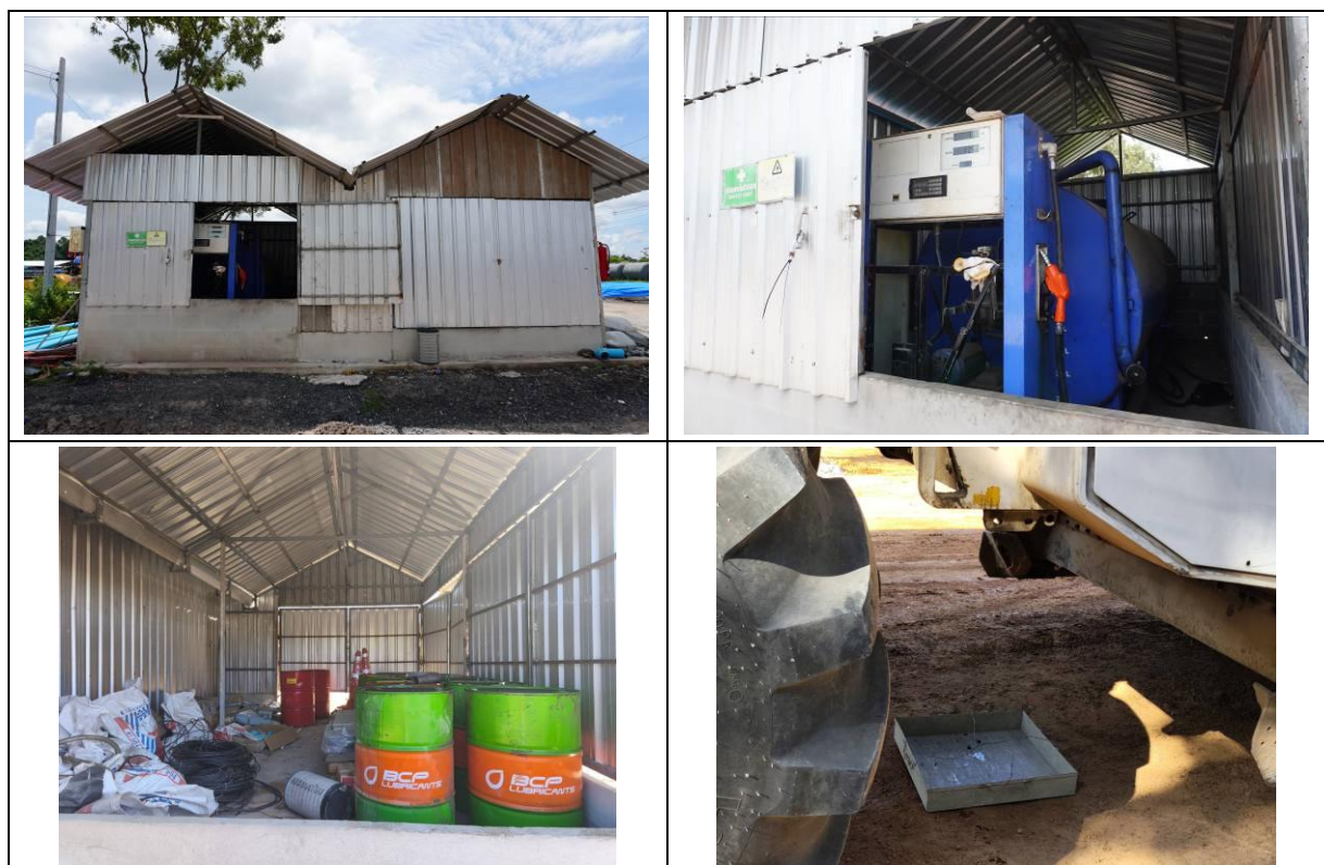
รูปที่ 3.1-9 การป้องกันการปนเปื้อนน้ำมันลงสู่ผิวดินและแหล่งน้ำ
